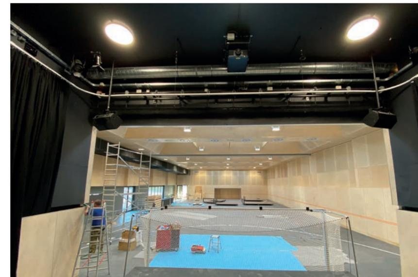
Die Bühne verfügt über eine umfassende Medientechnik wie zB. Beschallung, Hängemikros, Beamer, Großbildleinwand, LED-Scheinwerfer und einem elektrischen Vorhangsystem.
